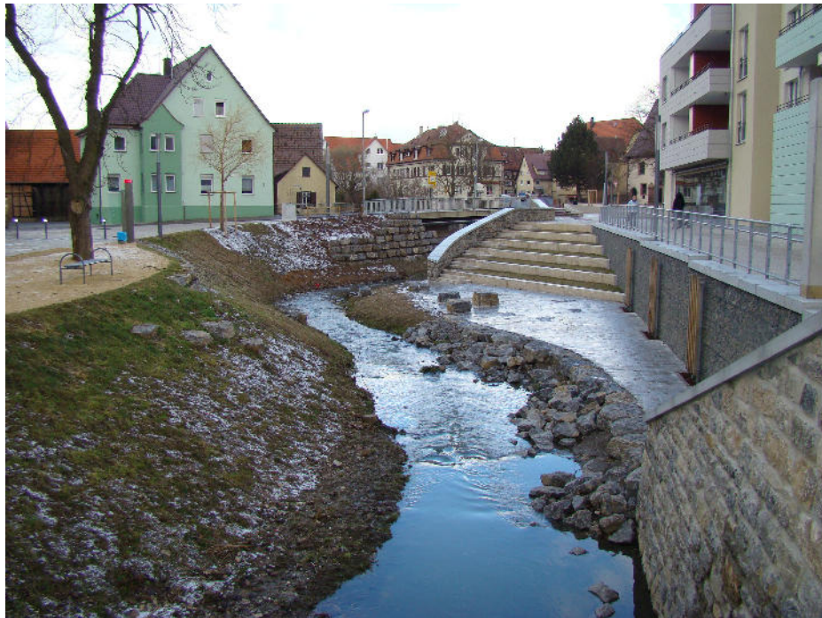
Abb. 13: Der Rankbach im Ortsgebiet von Malmshaus während der Umgestaltung
