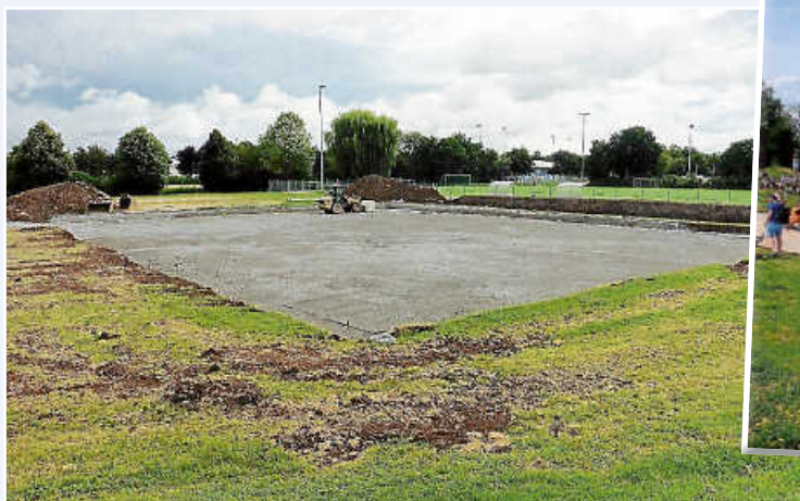
Vorher, während der Bauarbeiten auf der Freizeitanlage Hirschländer im Sommer 2020, Bild: Stadt Renningen
