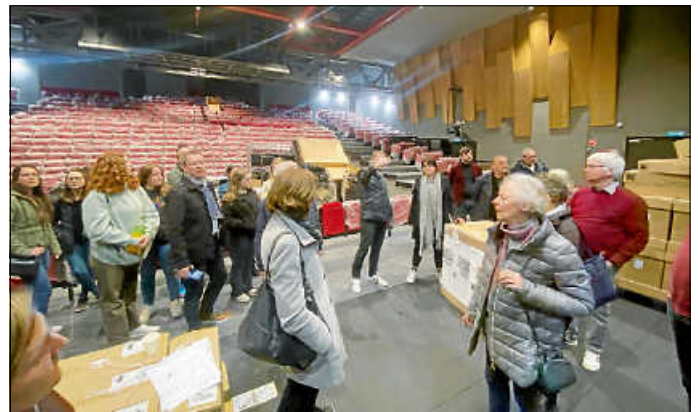
Bürgermeister Dugoin-Clément führt die Renninger Gruppe durch die Baustelle des auf nunmehr rund 700 Plätze erweiterten Theaters
