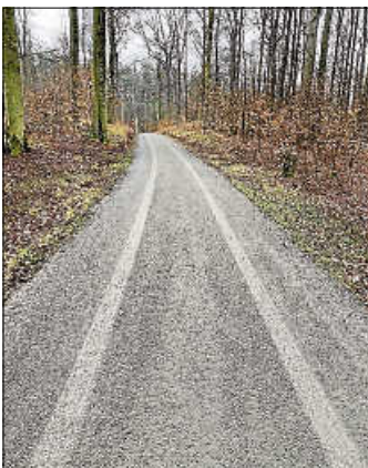
Der Fahrweg nach dem gleichmäßigen Auftrag der Verschleißschicht
