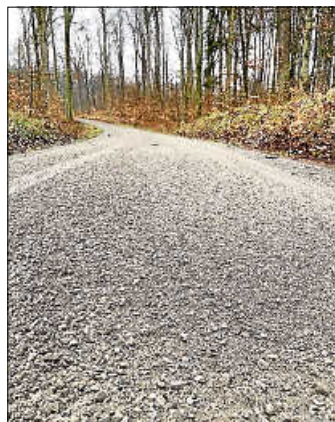
Die Verschleißschicht aus einem Korngrößengemisch von 0-8 mm
