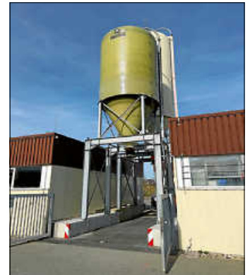
Das neue Salzsilo
