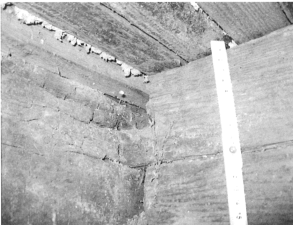
Abb.8 verschobene Schwelle Nordgiebel Raum 4
