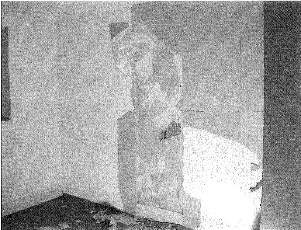
Abb.13-1 Wand f Raum E5
