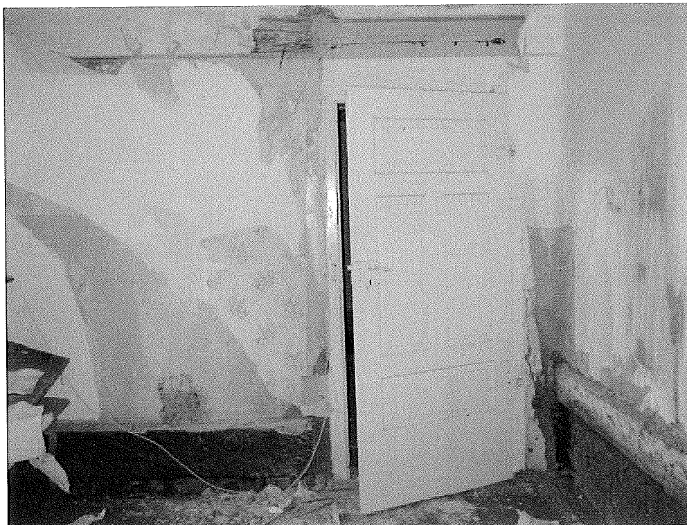
Abb.12-2 Wand b EG Raum E4
