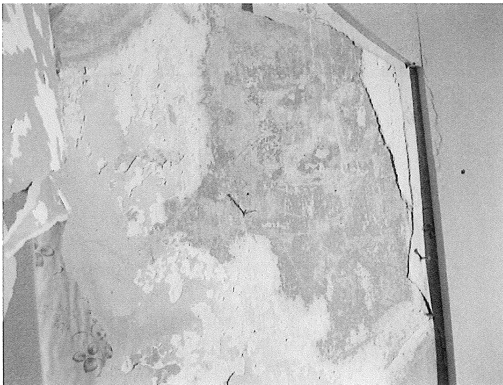
Abb.13-2 Farbe auf Putz Raum E5
